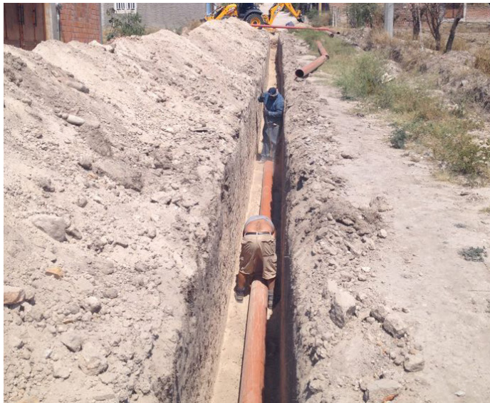
Foto: Rehabilitación de alcantarillado
