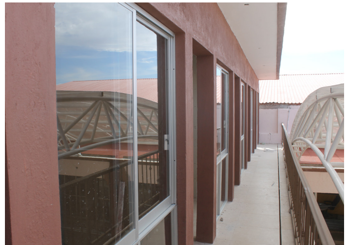
Foto: Rehabilitación de la Casa de la Cultura
