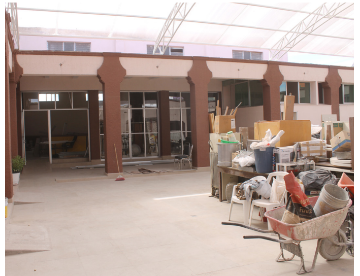
Foto: Rehabilitación de la Casa de la Cultura
