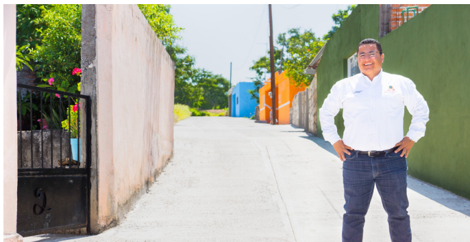
Foto: Construcción de calle en Tuitán
