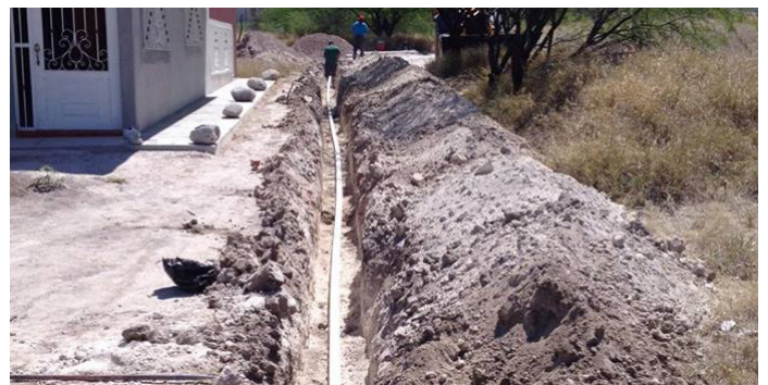
Foto: Rehabilitación y ampliación de redes de agua
