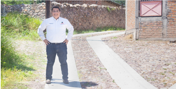
Foto: Pavimentación con concreto ecológico en San Bernardo
